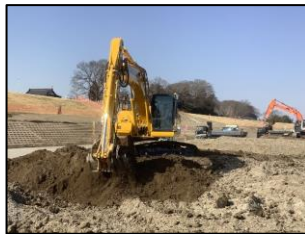
2種類のバケットアタッチメントを使用してICTバックホウにて土砂改良(攪拌)施工
