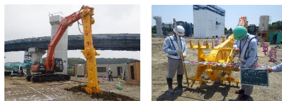
SCM 工法 【中層混合処理工法（機械式攪拌工法：スラリー攪拌）】
