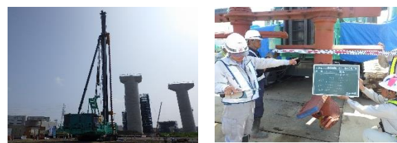
RMP-MST2 軸工法 【深層混合処理工法（機械式攪拌工法：スラリー攪拌）】
