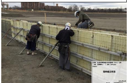
軽量型枠およびアルミパイプの使用
