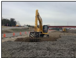
2種類のバケットアタッチメントを使用してICTバックホウにて土砂改良(攪拌)施工
