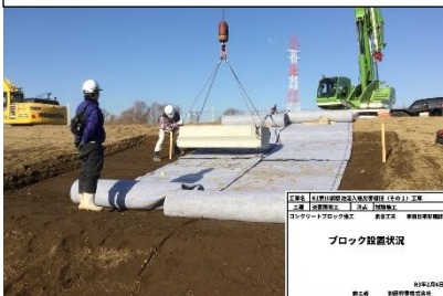
試験施工（圧密度確認）
