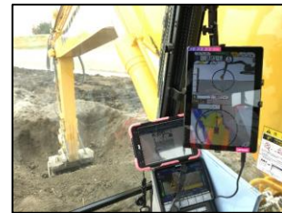
2種類のバケットアタッチメントを使用してICTバックホウにて土砂改良(攪拌)施工
