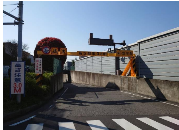
【応急処理(高さ制限補修)】
