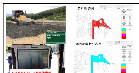
② GNSS による盛土締固め管理
