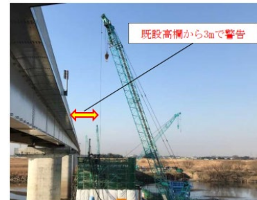
【クレーンマシンガイダンス(左：車内モニター、中：モニター画面、右：施工状況)】
