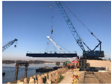
【仮橋施工状況（左：基礎杭打設、中：上部工架設、右：完成全景）】
