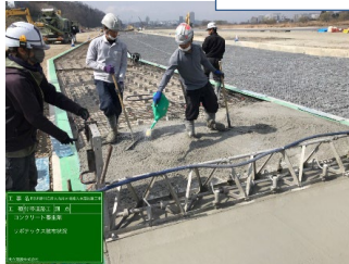
コンクリート舗装 散布状況
