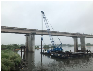
【仮橋施工状況（左：基礎杭打設、中：上部工架設、右：完成全景）】
