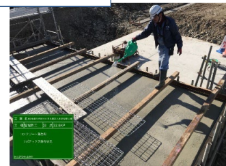
コンクリート舗装 散布状況
