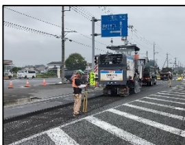
路面切削 ICT 施工
