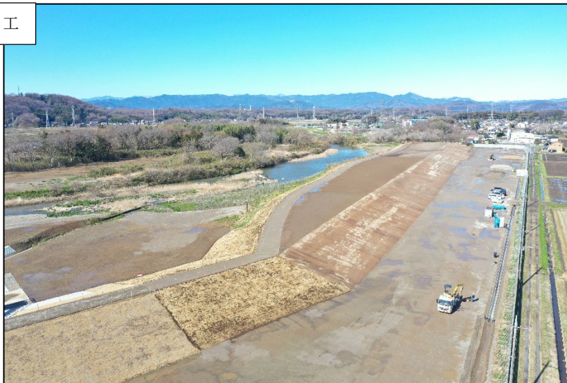
葛袋工区：河道掘削工
