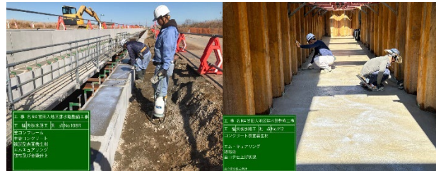
コンクリート舗装 散布状況
