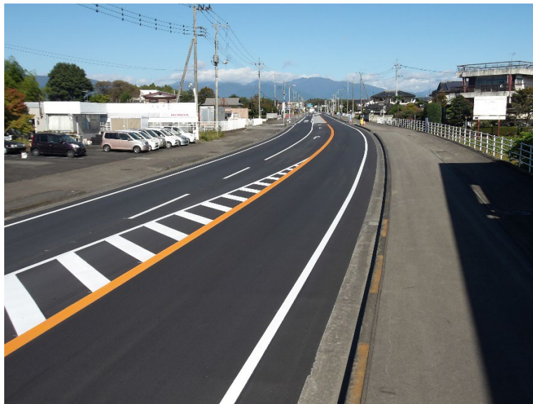
路面切削 ICT 施工【MC】
