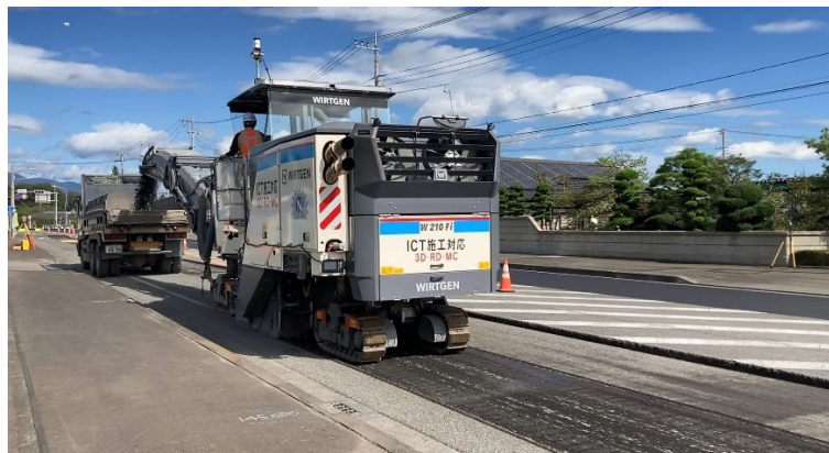
路面切削 ICT 施工【MC】
