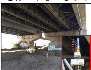
レーザーバリア警報監視システム
