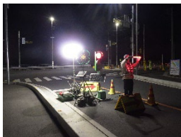
『仮設信号・仮設照明設備等の設置』
