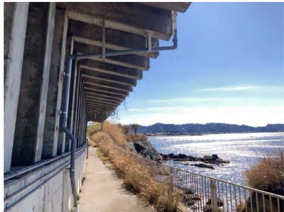
【金谷地区(排水管取替工)】
