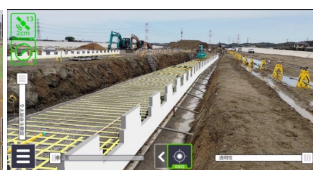
ARによる部材配置確認
