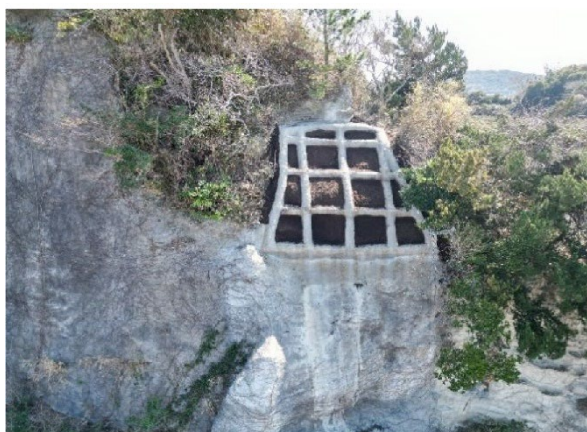
【豊岡地区(法面工)】
