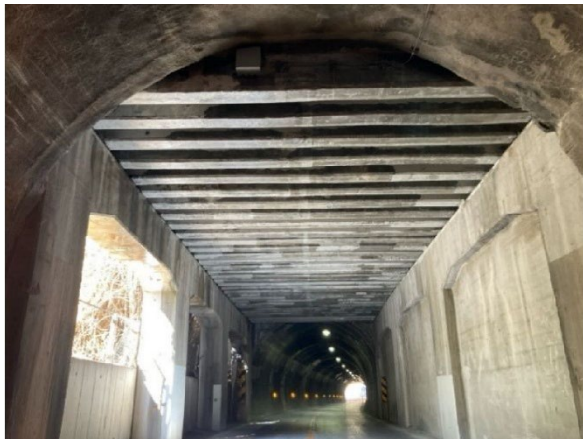
【金谷地区(構造物補修工)】
