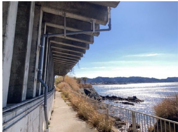
【金谷地区(排水管取替工)】
