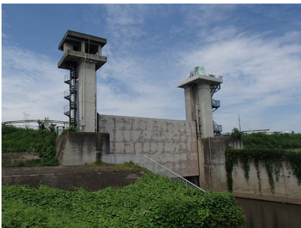
上屋工 着工前
