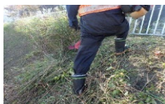
《傾斜地での作業状況》
