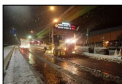
《除雪車で作業状況》
