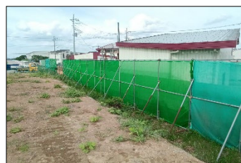
防塵ネット設置
