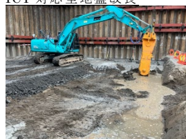
ICT 対応型地盤改良
