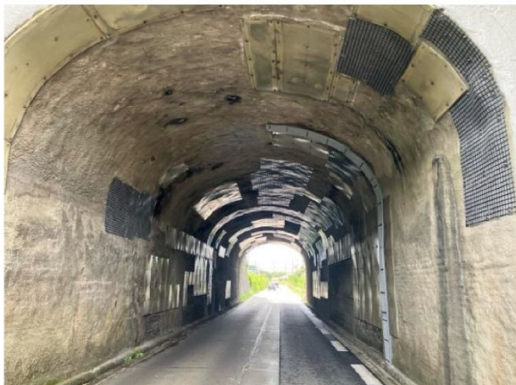
【萩生地区(構造物補修工)】
