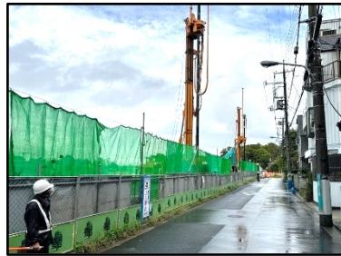
地盤改良施工時
