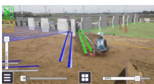
ARによる部材配置調整作業
