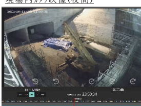
現場内カメラ映像(夜間)
